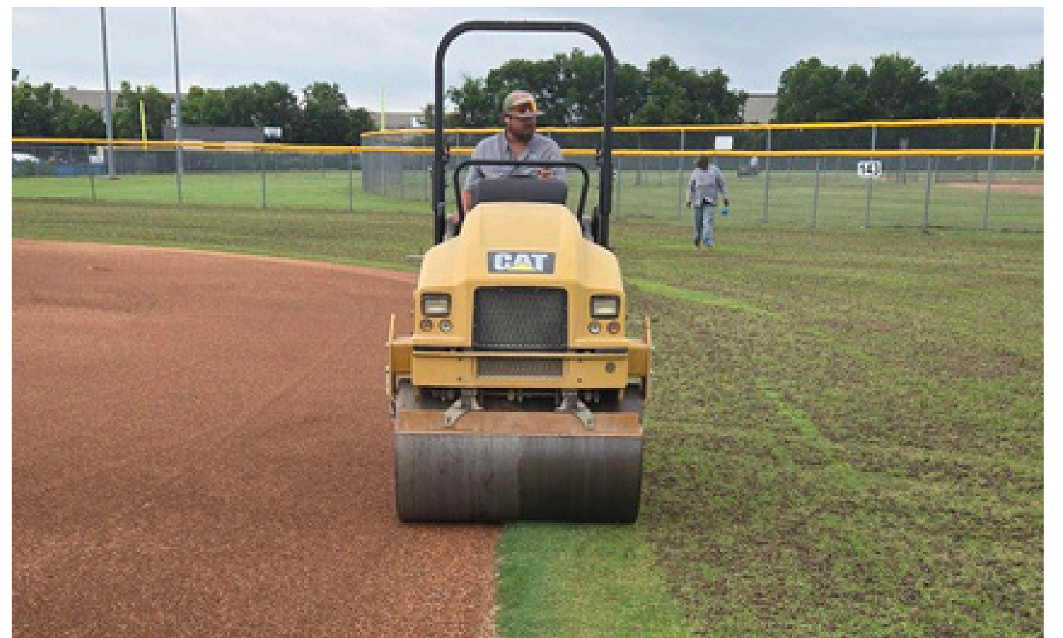
LEON TUTTLE MINI FIELD RENOVATION
